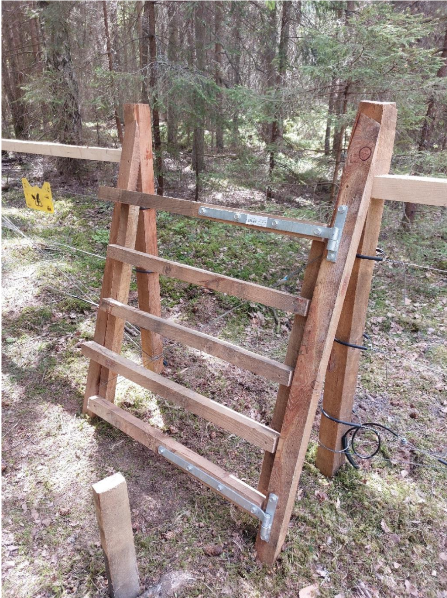
Bild 6. Bilden visar en ny självstängande grind. LIFE-bricka saknas fortfarande men ska fästas snart. Foto: Sari Roponen 2023-06-02 (ObjektID 16037).
