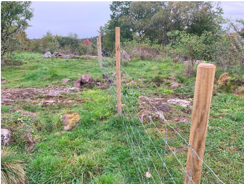
Figur 4 Stängsel klart på en delsträcka norr om Stortorps gård. Fårnät för att hålla betesdjur inne och vildsvin ute (hösten 2023). Återstår endast en eltråd på distanser över nätet. Foto: Thomas Johansson.
