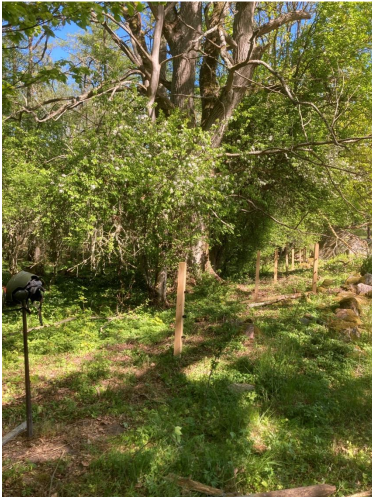
Bild 11. Nytt stängsel under byggnadsfasen. Foto: Sari Roponen 2022-05-18 (ObjektID 605).
