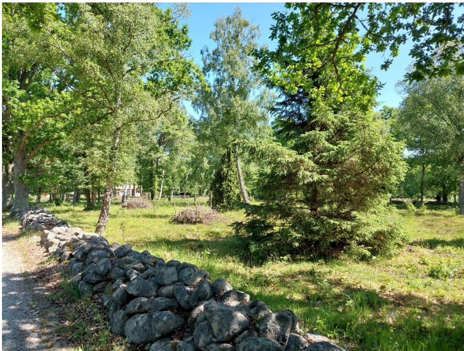
Före restaurering, taget med P i ryggen
