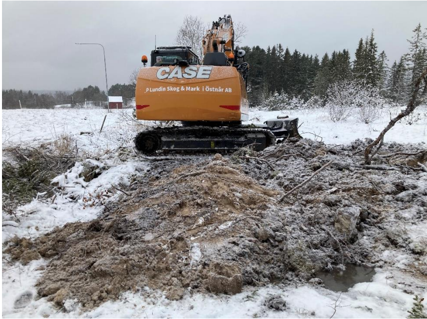
Igenläggning av dike i november 2022.
