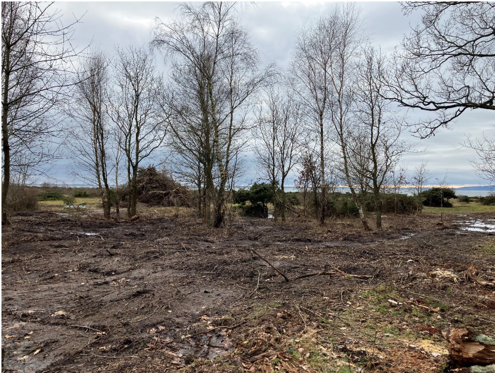
Efter röjningar i Vasalt där buskar har dragits upp med rötter och marken skrapats av.
