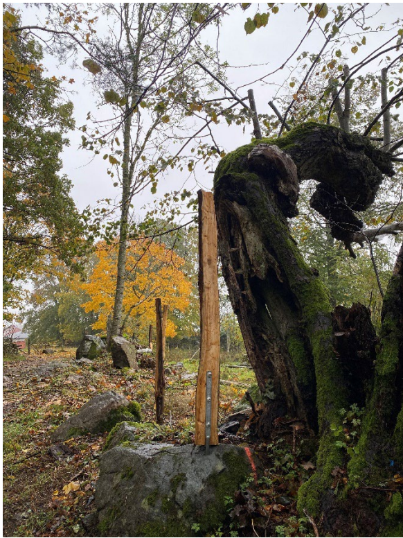
Foto. En del stolpar monterades med järn på markbunden sten för att få till ett bra stängsel.
