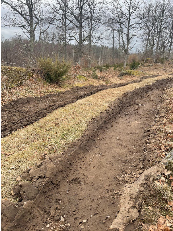
Foto. I samband med flisningen tidigt på våren 2025, kördes den långa vägen ut på Ånäset sönder och den fick sedan lagas med i fyllnad av grus och tilljämning under maj.
