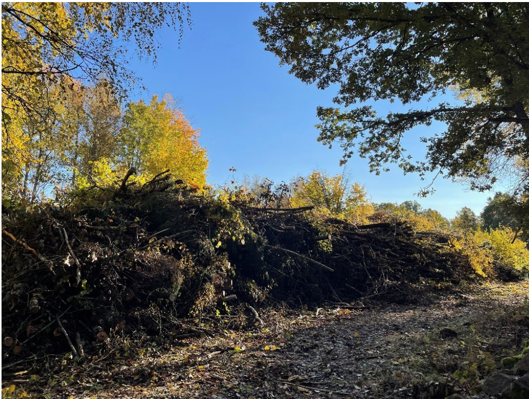
Foto. Flismaterial samlades på en åkeryta ute på Ånäset och virket kördes ut varje avslutad arbetsdag.
