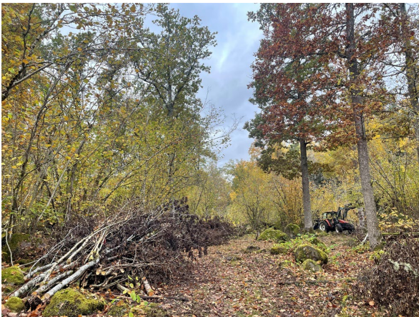
Foto. Utkörning av mycket material men ett antal högar med hassel lämnades kvar i området.
