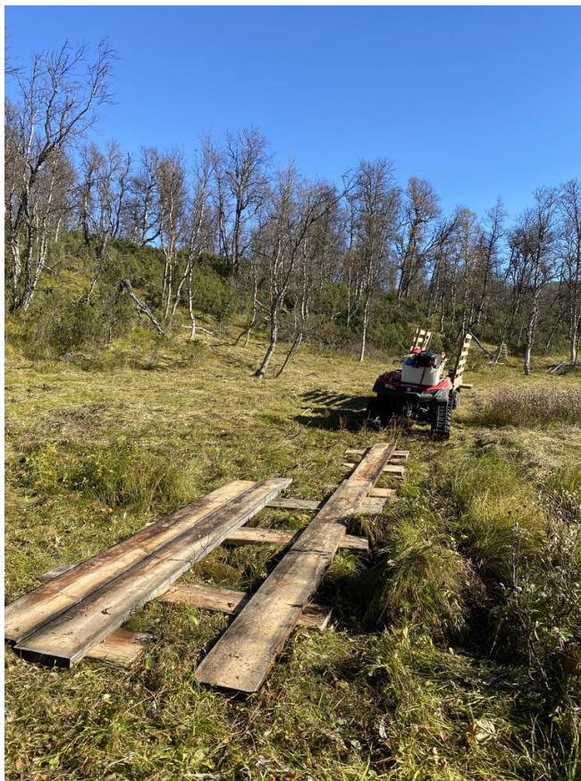
En enklare bro som byggts för transport med fyrhjuling.
