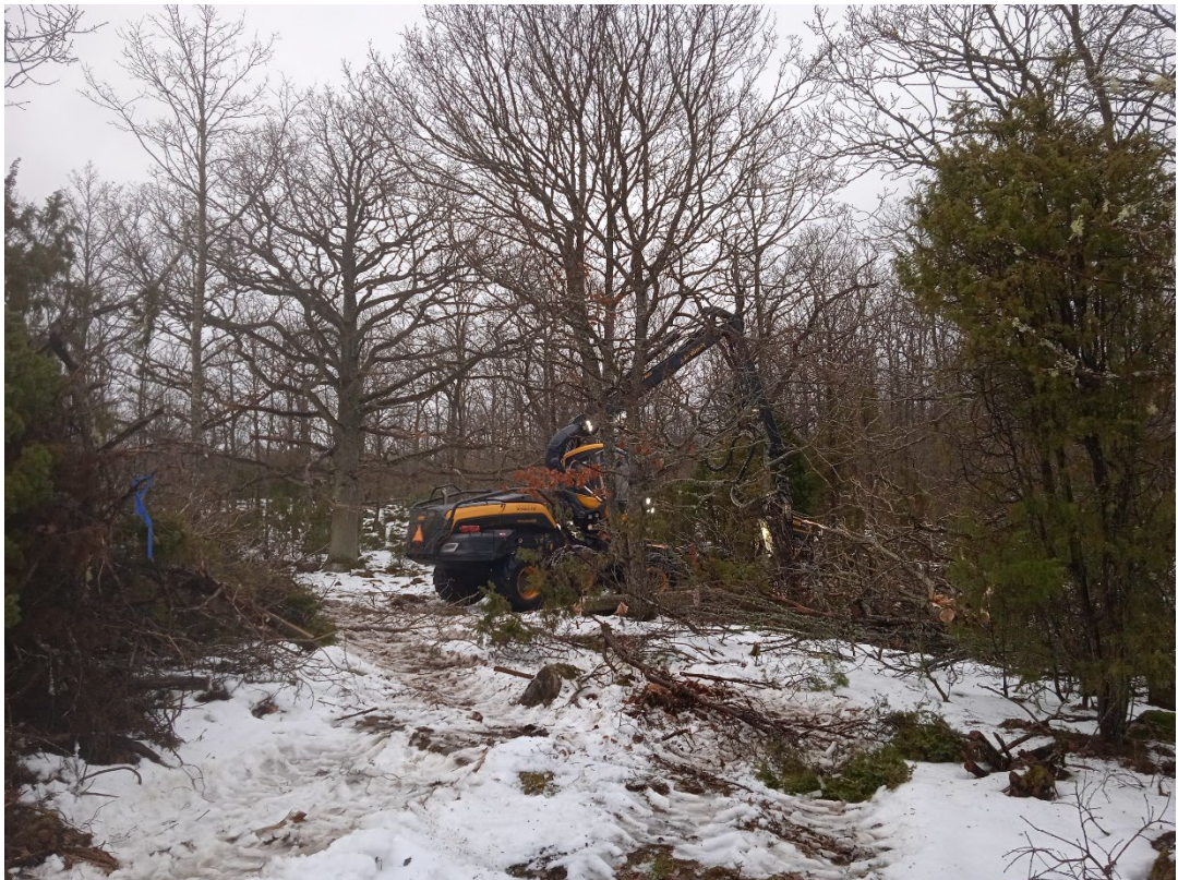
Under pågående åtgärd januari 2024.
