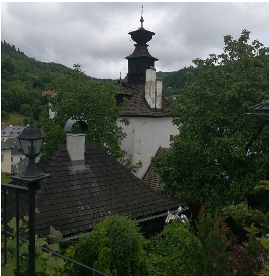
Figur 38. Klopáčka-tornet i renässans-barock stil från 1681 med spåntak. Här kallades gruvarbetarna till sina skift förr i tiden med hammarslag.
